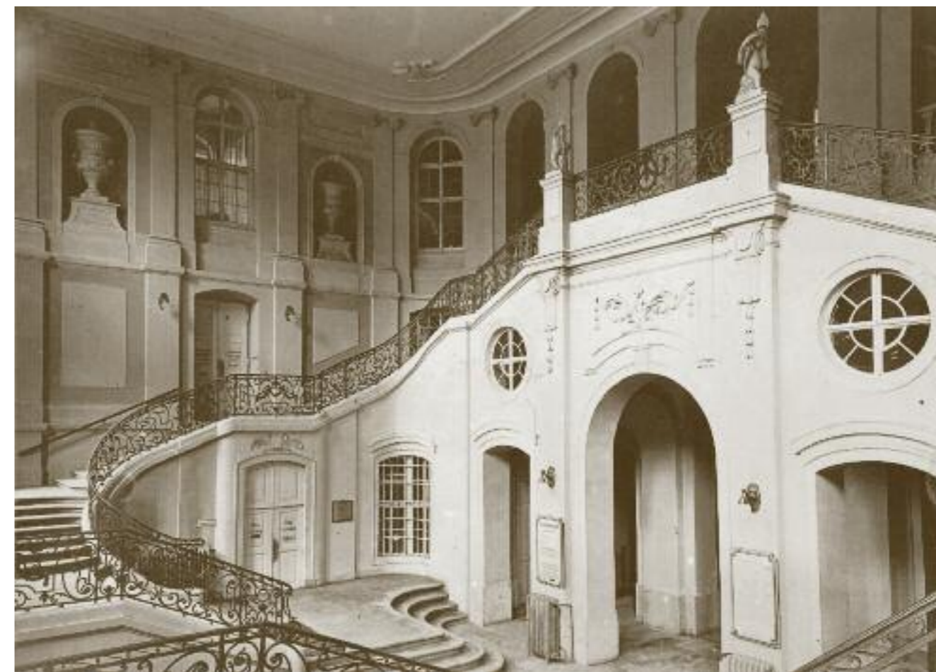
Treppenhaus des Dresdner Landhauses
